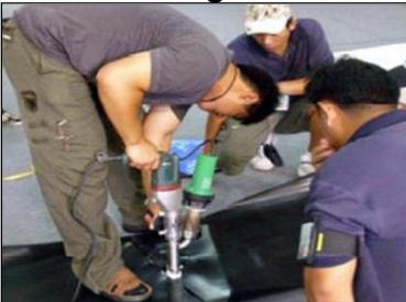
Conexión de la geomembrana y sistema de captación de agua.
