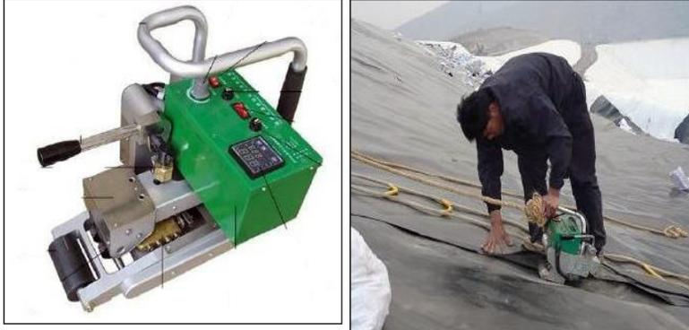
**Figura N°2** Obrero realizando el armado de la bolsa de geomembrana.
