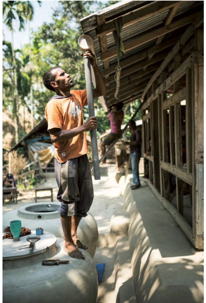
Installation d'un système de captage des eaux de pluie au Bangladesh
