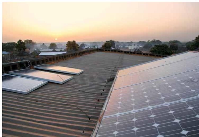
Die Solarpanels, die die Wasserpumpe betreiben, sind auf dem Dach der Gesundheitsstation montiert.
