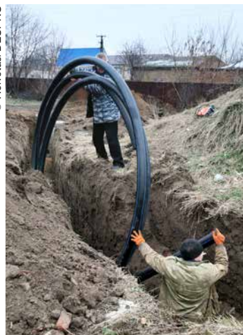
Reparatur der Wasserversorgung in Makariw.
