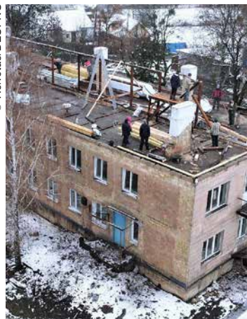
Wiederaufbau in Borodjanka.
