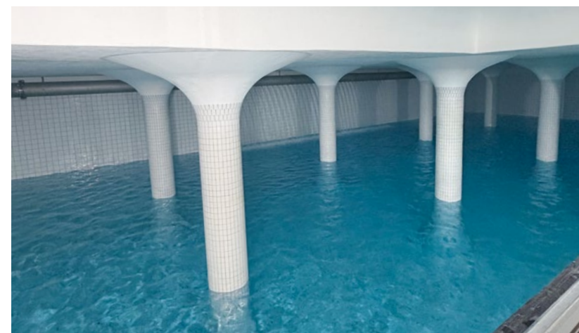
Un réservoir d'eau en Suisse. Avant de jaillir de nos robinets, l'eau suisse est contrôlée plus d'une fois.
