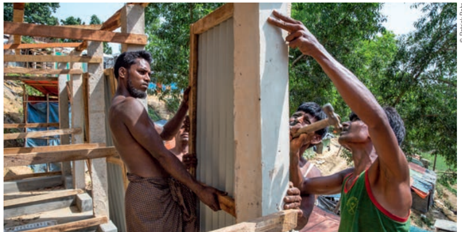
Die Mitarbeit beim Bau von Latrinen ermöglicht einen seltenen Zusatzverdienst.
