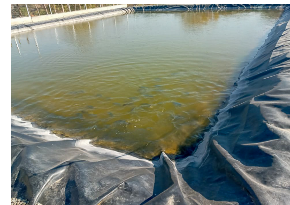
Figura 7. Estanque revestido de geomembrana 300 m 2 del CPA-Suyo.
