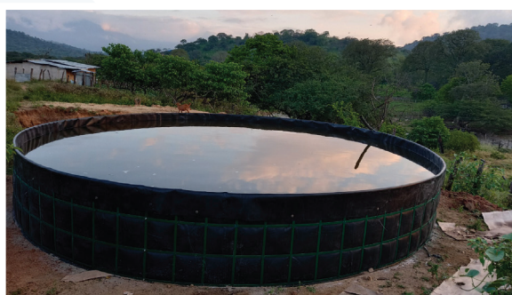
Estanque circular de geomembrana (geotanque).
