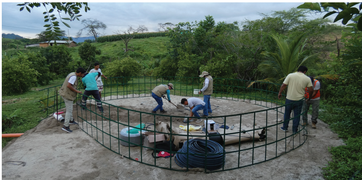
Instalación de geotanque - comunidad la Tina.
