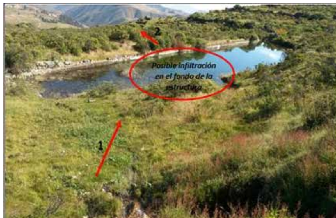
FIGURA 3 - BALSAS, ALMACENAMIENTO Y POSIBLE INFILTRACIÓN (FUENTE: INVESTIGACIÓN MAMANTEO, CONDESAN 2015)
