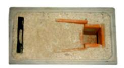
10. Aislante piedra de poma: Se utiliza piedra poma o arena blanca y ceniza de madera para completar el proceso de instalación, es muy importante nivelar las paredes de la base interna ya que la arena blanca sirve de aislante entre la cámara de combustión y la base de fundida para evitar un recalentamiento en la parte exterior.
