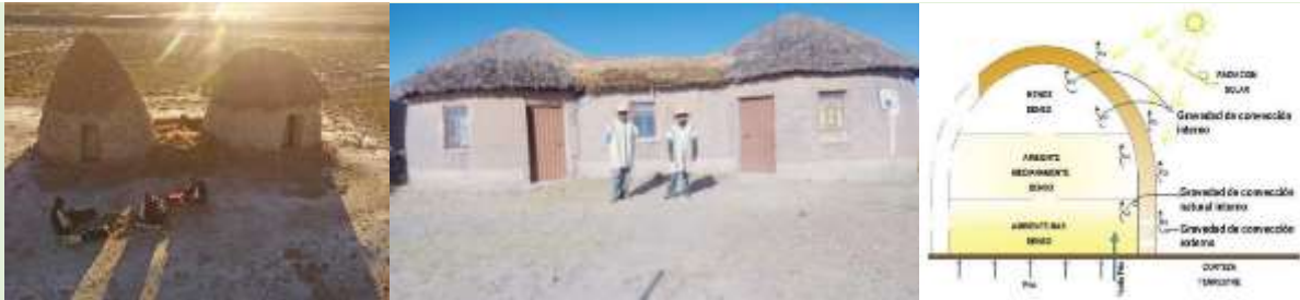
Vivienda tradicional uru chipaya (Di Cósimo, 2018), vivienda tradicional iruhito uru (Machaca & Inda, 2014); esquema del flujo de energía (calor) en las casas de Llapallapani (Nuñez et al. 2018 en Velásquez, 2020); .
