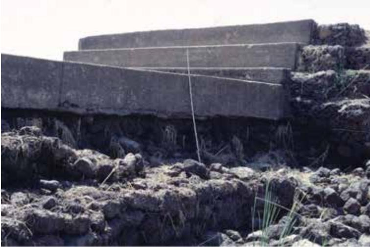
37. Saisonspeicher in Burkina Faso, Hochwasserentlastung an falschem Ort, sollte nicht in Dammmitte sein (grosses Erosionspotenzial), sondern am Dammhöhe ausläuft
