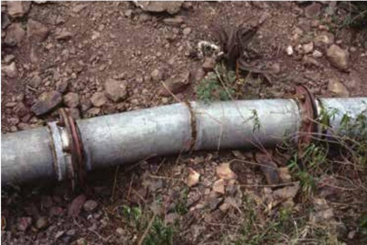
31. Kenia, Stahlwasserleitung direkt auf Fels verlegt, Gefahr der Beschädigung, Problem der Wassererwärmung
