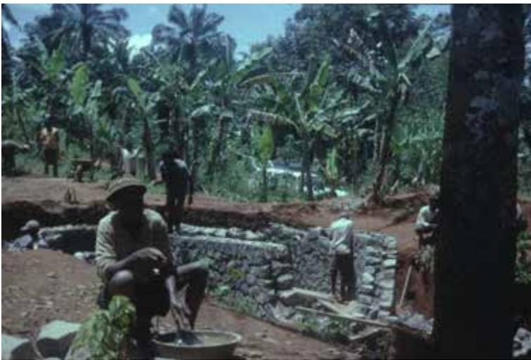
38. Reservoir-Bau in Kamerun; dank lokalem, gutem Steinmaterial ist Zement- und Armierungsstahlverbrauch minimal
